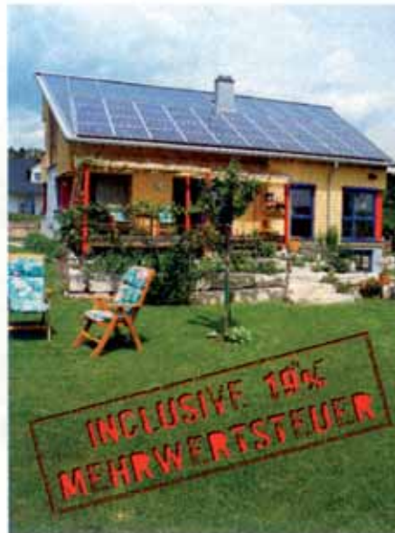
Eine dachintegrierte Photovoltaikanlage verhilft zur Stundung der Umsatzsteuer für das ganze Haus.
