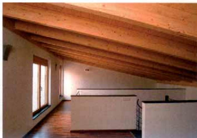
... mit zusätzlichem Raum im angeschnittenen Dachstuhl.
