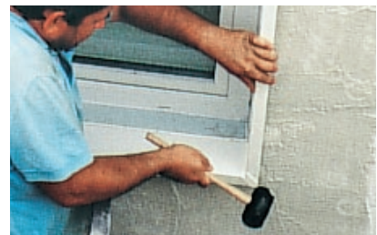
4. Durch Einschlagen in die Nut befestigen (z.B. Gummihammer). Abdichtung zwischen Dämmungsanschlussprofil und Fassade kann mit handelsüblichen Dichtstoffen erfolgen.
