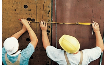
1. Leibungsfenster/Stützkreuz einmessen.
