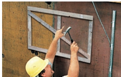
3. Stützkreuz auf der Schalung befestigen.
