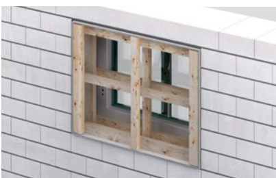
4. Aussteifungen erst nach Erhärten des Mörtels entfernen.
