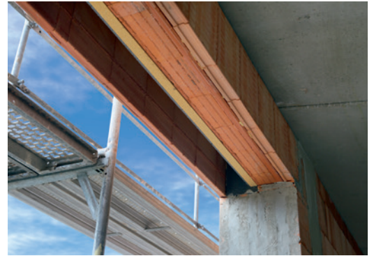
Der mit Perlit gefüllte Jalousiekasten ROKA-LITH-SHADOW ermöglicht einen einheitlichen Putzgrund. Bei großen Fensteröffnungen und in Bereichen mit reduzierter Auflagertiefe erfolgt eine zusätzliche Verankerung in der Stahlbetondecke.
