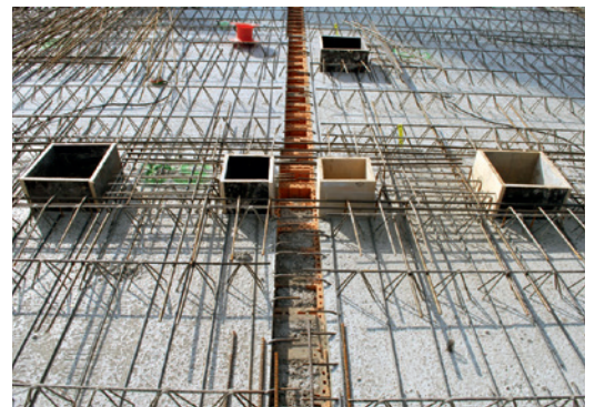
Poroton-Planfüllziegel PFZ-T wurden für die Wohnungstrennwände eingesetzt. Das Füllen mit Frischbeton erfolgt rationell zeitgleich mit dem Gießen der Deckenplatten.
