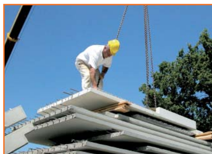
1. Anlieferung und Entladung mit dem Romey-Spezialfahrzeug bzw. einem Baustellen- oder Autokran.
