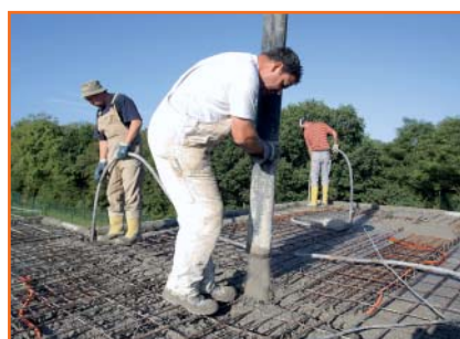
5. Vergießen der Deckenelemente mit Beton.
