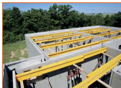
2. Positionierung der Unterjoche gemäß der von uns erstellten Montageanleitung.
