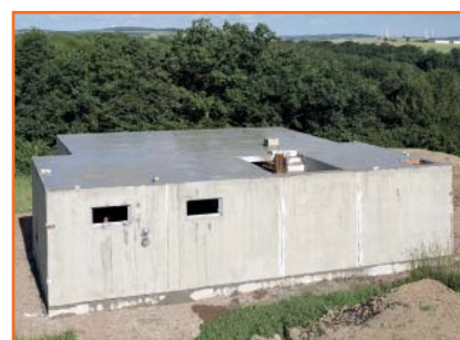
6. Fertig abgezogene Decke.
